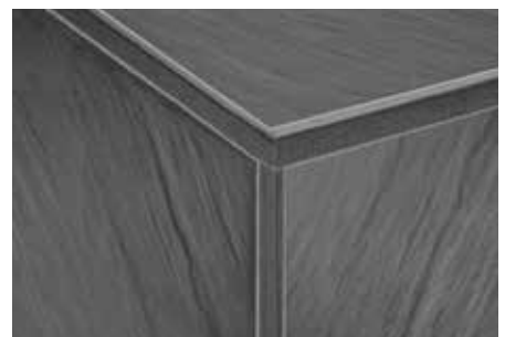
Ejecución de esquinas con corte a inglete
